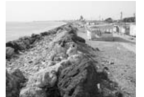
気候変動の影響で悪化した海岸浸食。セネガル政府による基礎工事を適応基金の支援で補強する（出典：Centre de Suivi Ecologique）
