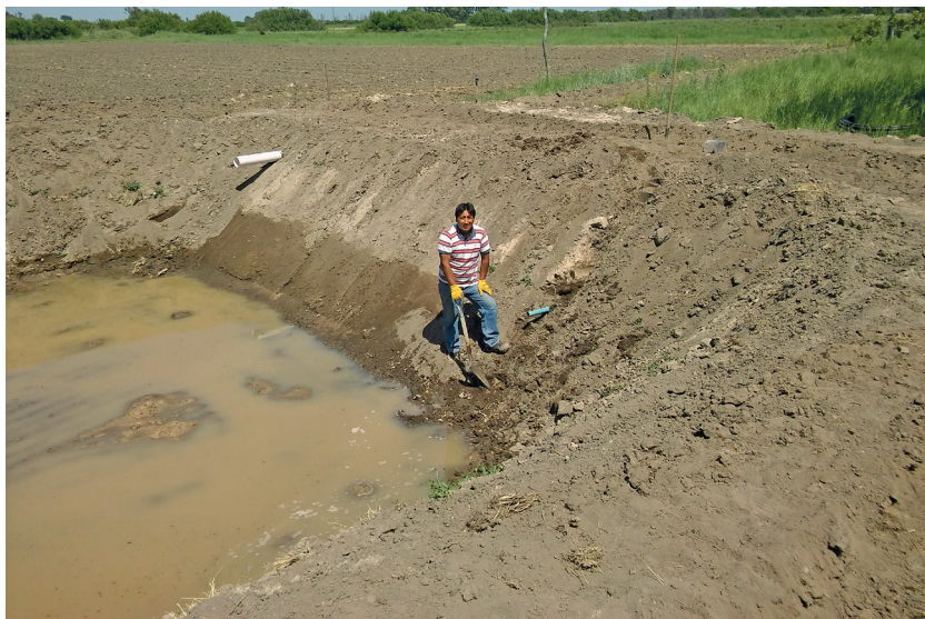
Foto 12. Instalación de tubo de PVC para el ingreso de agua al reservorio.
