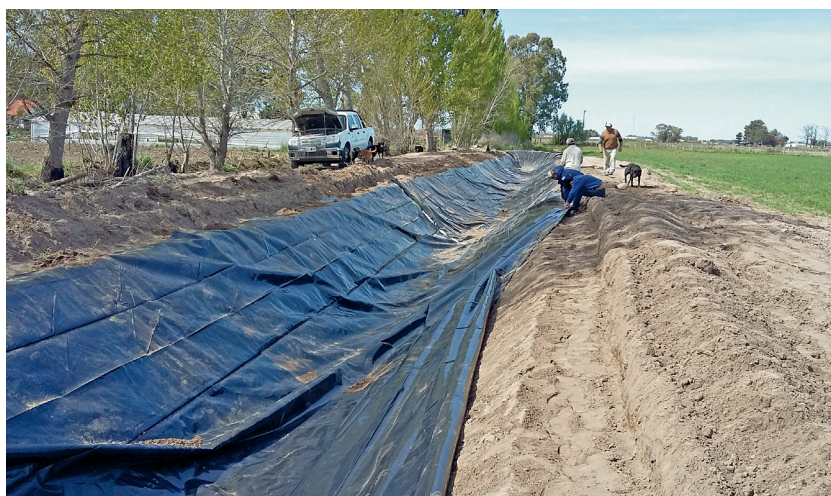
Foto 11. Fijación de la membrana de polietileno al suelo sobre el terraplén del reservorio.
