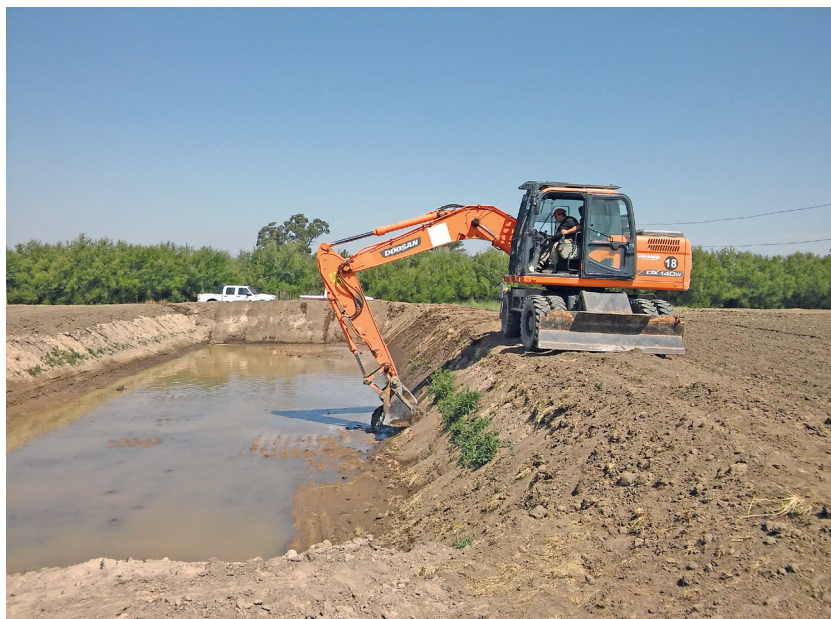
Foto 4. Trabajo de excavación y perfilado del talud con excavadoras.
