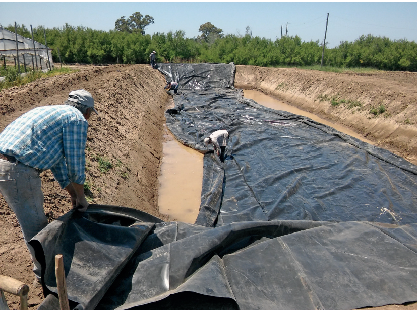
Foto 10. Tareas de revestimiento de reservorios en presencia del plano freático.
