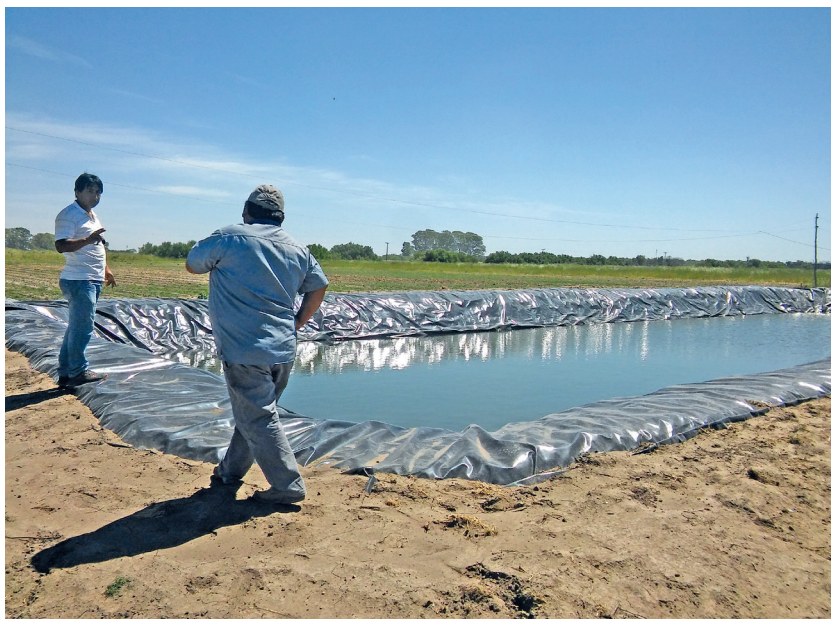
Foto 14. Reservorios terminados y en funcionamiento.
