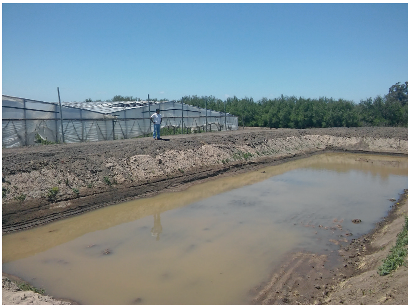
Foto 3. Plano freático visible y a escasa profundidad luego de la excavación.
