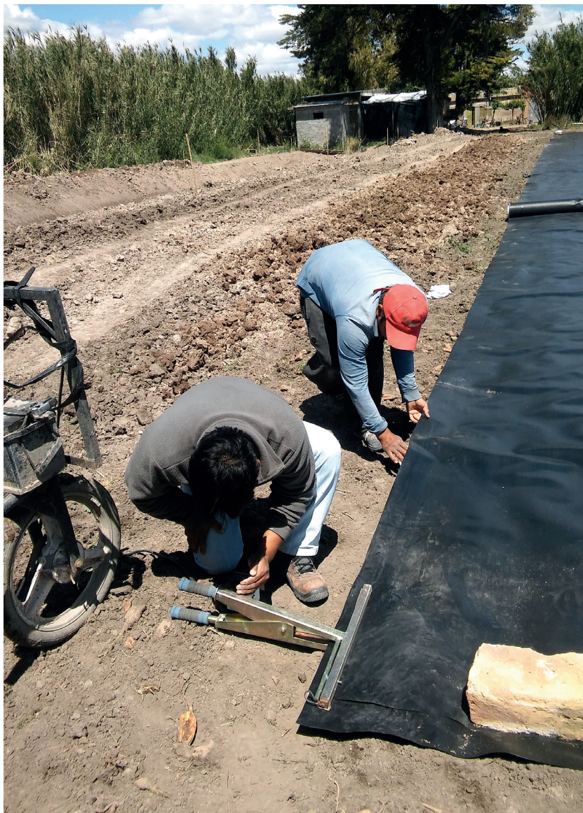
Foto 9. Sellado de mantas de geomembrana con selladora de silo bolsa TSSB50 Breso Pack.
