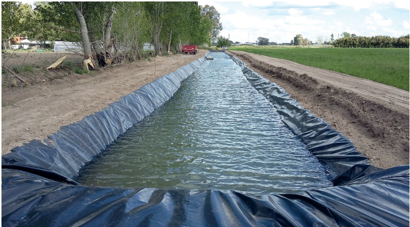
Foto 6. Revestimiento de reservorio con mantas de geomembrana de 500 micrones.
