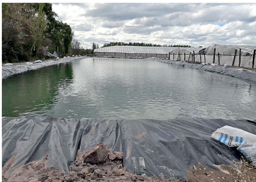
Foto 2. a) acequia interna ensanchada, profundizada y revestida, convertida en reservorio; b) reservorio excavado rectangular próximo a los invernaderos.
