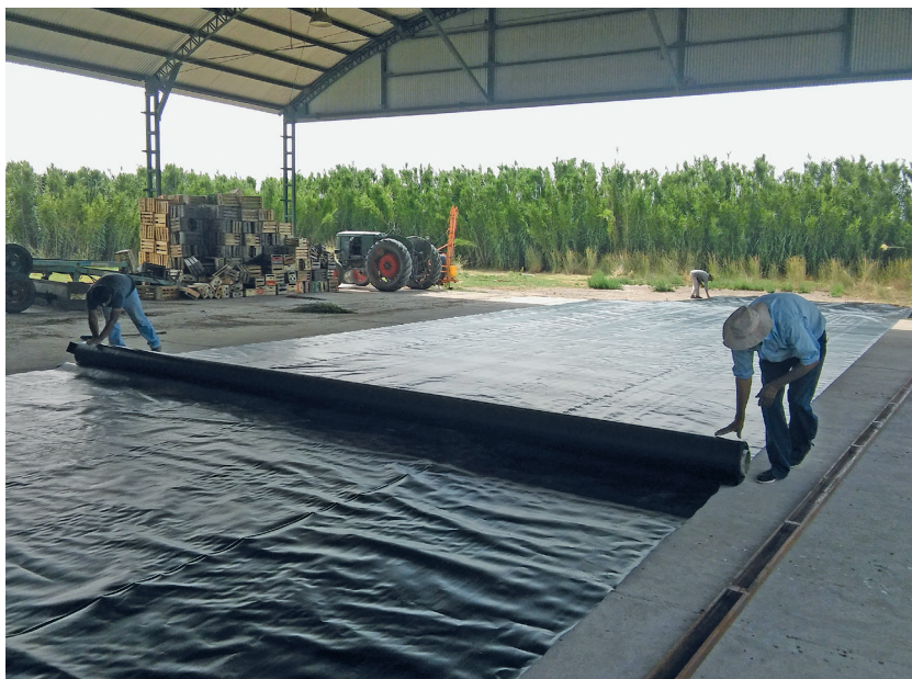
Foto 8. Transporte, despliegue y preparación de las mantas para su unión por termofusión.
