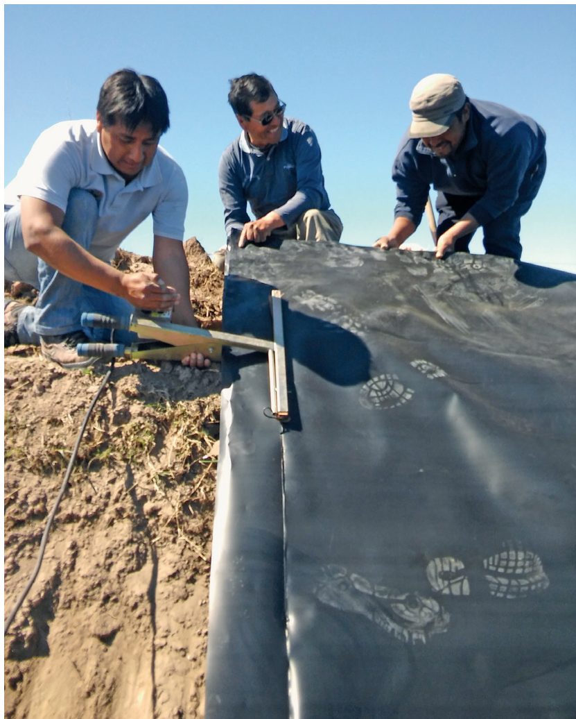
Foto 9. Sellado de mantas de geomembrana con selladora de silo bolsa TSSB50 Brespack.
