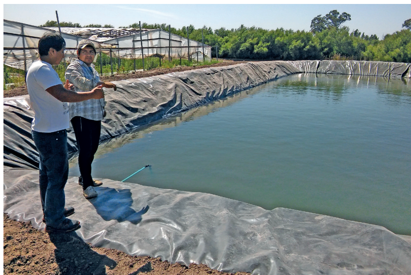
Foto 14. Reservorios terminados y en funcionamiento.
