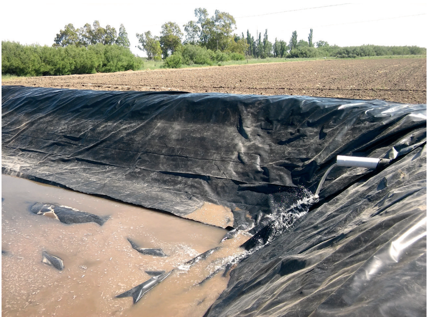
Foto 13. Ingreso de agua a al reservorio una vez revestido.
