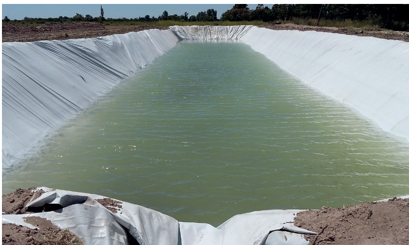
Foto 7. Revestimiento de reservorio con mantas de silo bolsa de 150 micrones.
