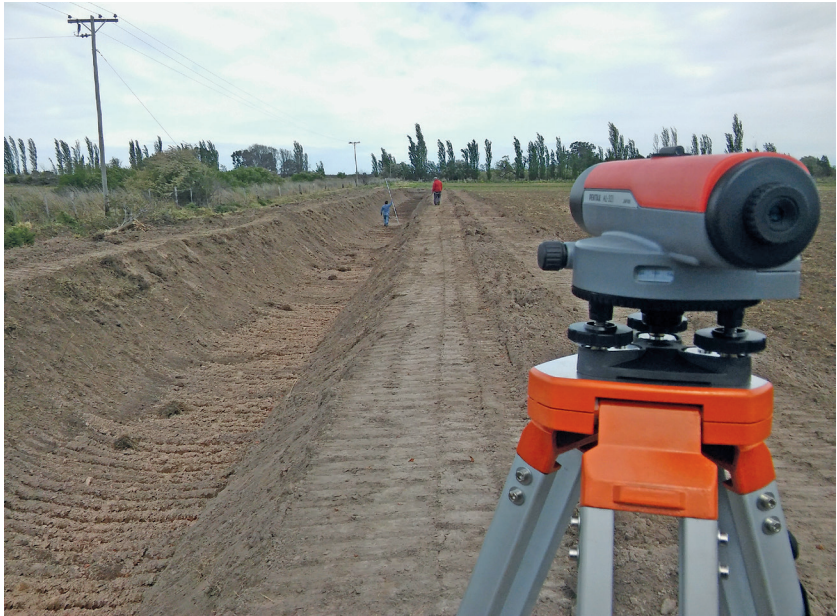
Foto 1. Tareas de nivelación con nivel de anteojo Pentax AL -321 32x.
