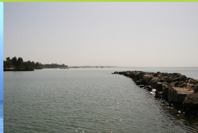
Des barrières comme celles-ci contribuent à freiner l'érosion extrême. Photo CSE
