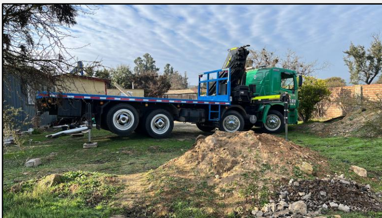
Preparación del terreno en Escuela Los Molles
