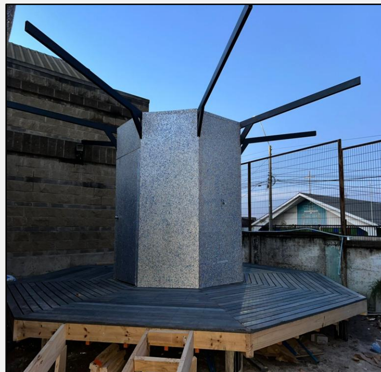
Construcción del tanque de agua en el Colegio Darío Salas
